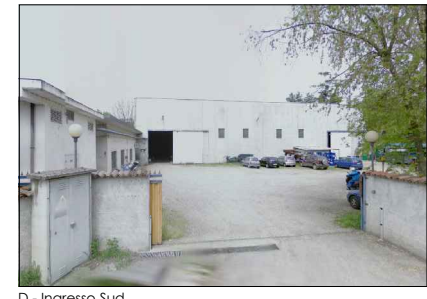
D - Ingresso Sud
